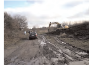
Die Arbeiten für die Beobachtungsstation am Appener See haben im
