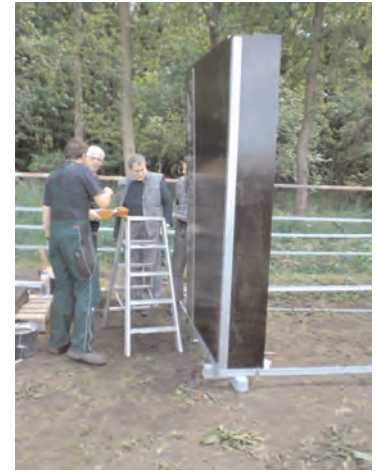
Bau von mobilen Weidehütten durch Maßnahmeteilnehmer
